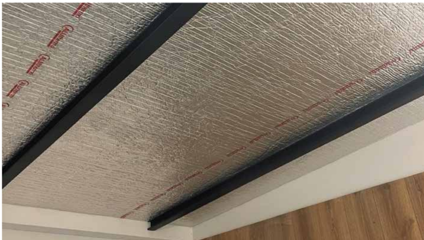
Przykładowa realizacja w systemie międzykrokwowym
